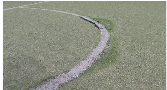
Uneven turfing at Riviere du Rempart Mini Soccer Pitch
